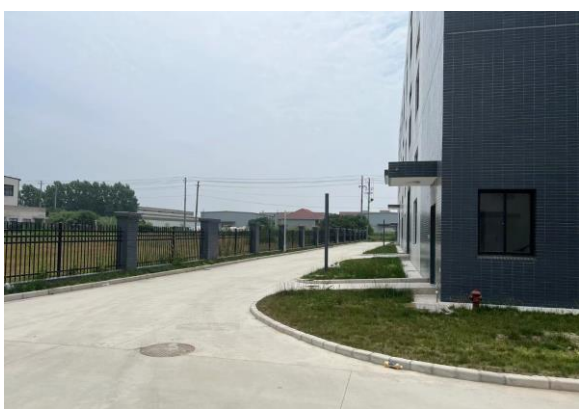
道路硬化及绿化现状 (3)
