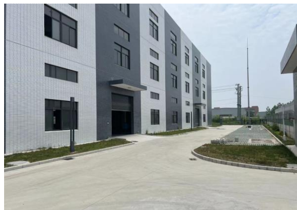
道路硬化及绿化现状 (4)
