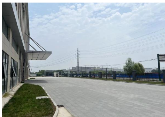
道路硬化及绿化现状 (2)
