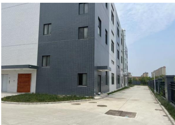
道路硬化及绿化现状 (1)
